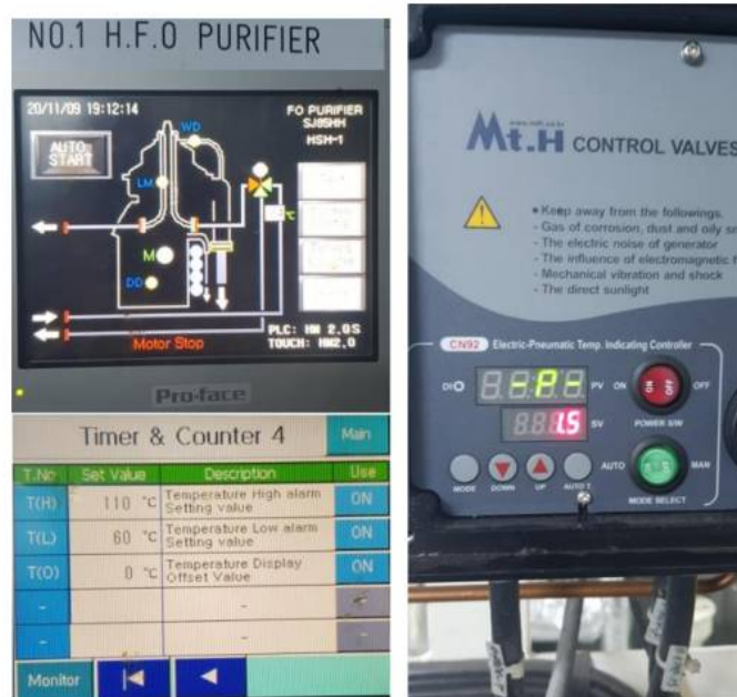
Slika 59. Prikaz tipa separatora, temperature alarma i izgleda PID podešavanog kontrolera
